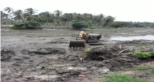
ඡායාරූප - 15 - හලාවත මහවැවෙහි අවිධිමත් ලෙස රොන්මඩ ඉවත් කිරීම
