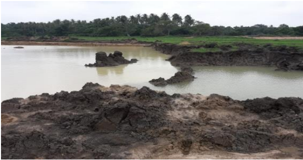
ඡායාරූප 13 - බෝගොඩ වැවෙහි වැලි නිස්සාරණය කිරීම සඳහා අවිධිමත් ලෙස පස් ඉවත් කර තිබූ ආකාරය
