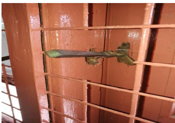
ඡායාරූපය 10 - අනුමත ප්‍රමිතියන්ට අනුකූල නොවන ලෙස ඉටු කර තිබුණු විද්‍යාලයේ අළුත්වැඩියාවන්
